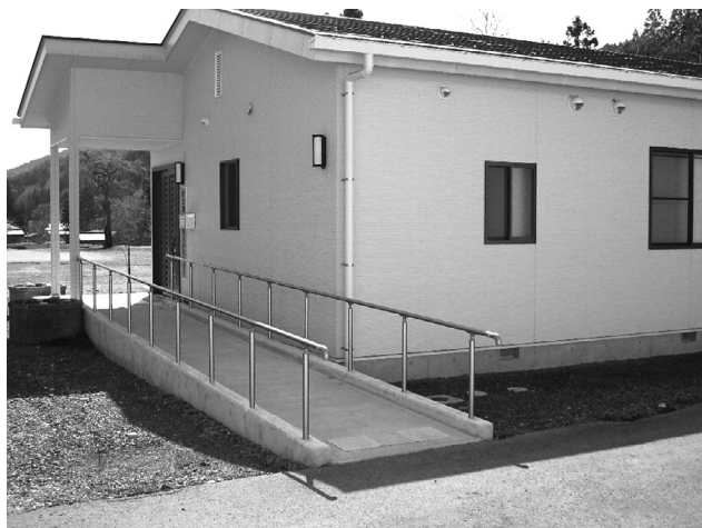
車いすでの投票が可能なバリアフリー化された投票所
