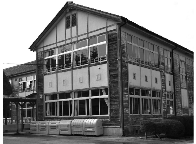
現在の大田原小学校の木造校舎
