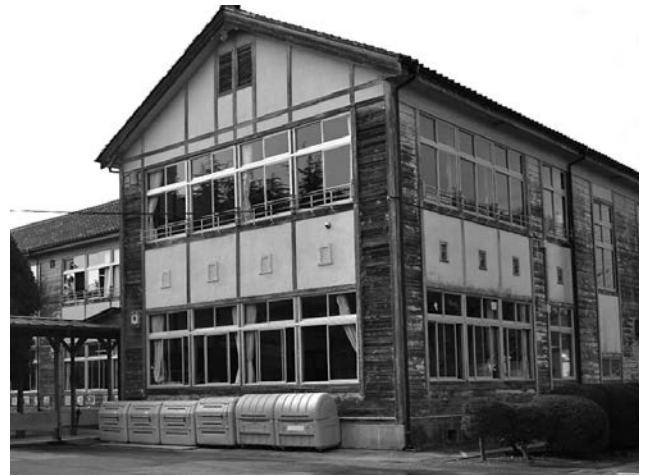
現在の大田原小学校の木造校舎
