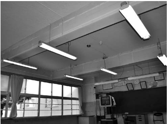
学校内の照明器具などの非構造部材の耐震化を図る必要があります
