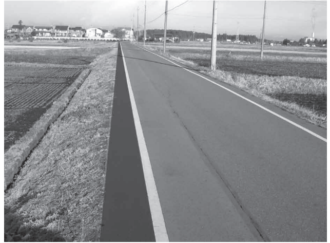
路肩カラー舗装化を進めています
