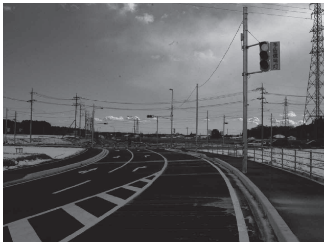
アクセス道路の整備を進めています
