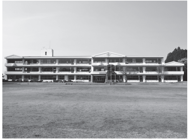
現在、使用されていない旧川西中学校
