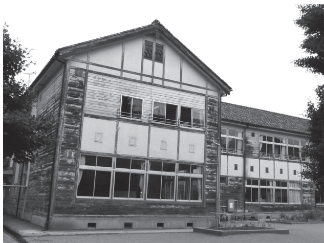
大田原小学校の木造校舎
