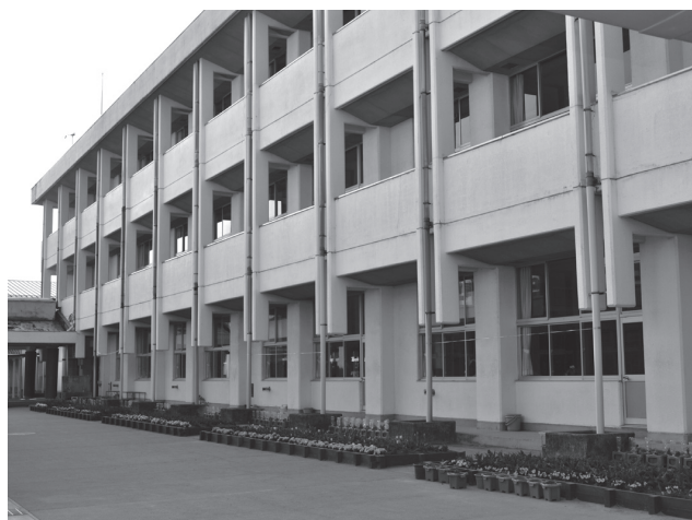
今年度、耐震補強工事が予定されている西原小学校
