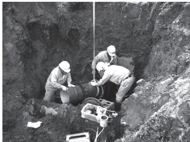
震災での配管復旧作業
