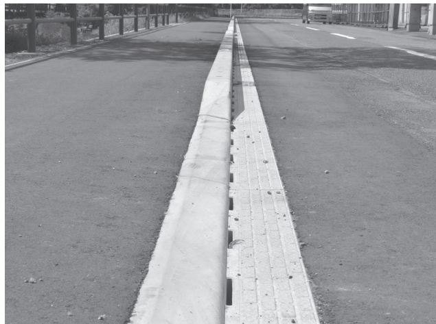
都市型側溝による施工箇所(鶯谷公園前)
