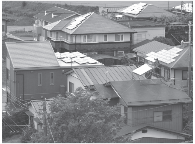
太陽光発電パネルを設置している住宅が増えています
