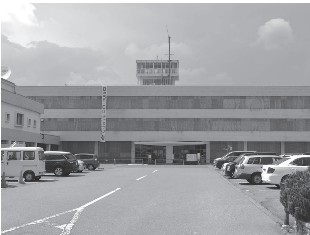
ガラスの落下を防止するため板で覆われた本庁舎
