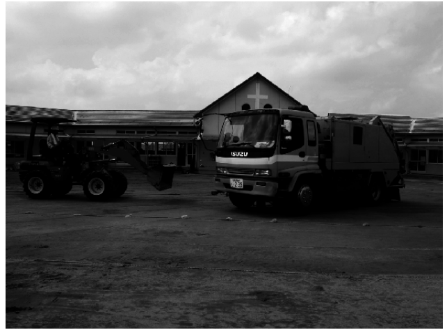
黒羽幼稚園の表土除去作業
