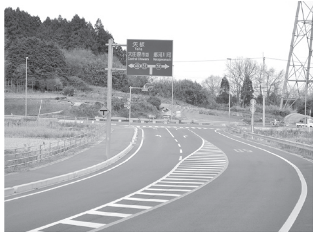
バイパス工事着工に向けた取り組みを進めています
