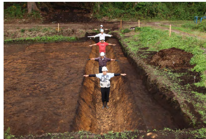
SD03 掘削完了状況(東から)
