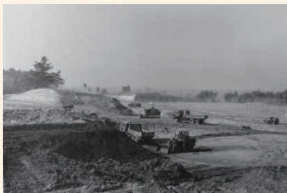
陸上競技場造成工事（昭和60年）
