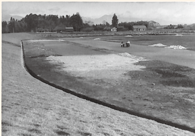
陸上競技場の建設風景(昭和27年)
