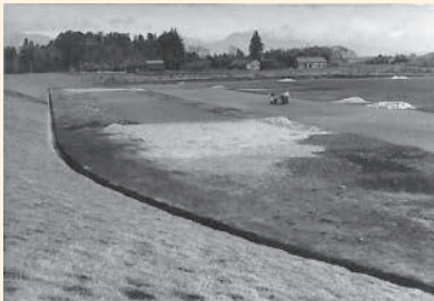
陸上競技場の建設風景(昭和27年)
