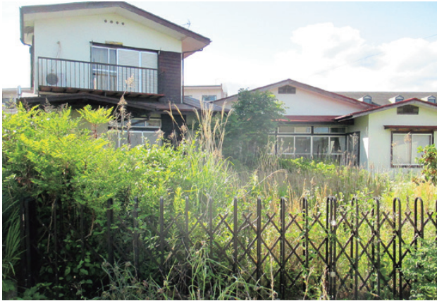
《草木が繁茂している空き家》
