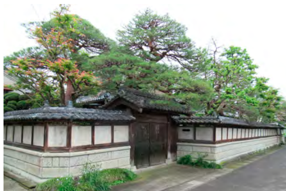
旧大田原城下に遺る建造物
