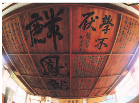
旧作新館講堂格天井
