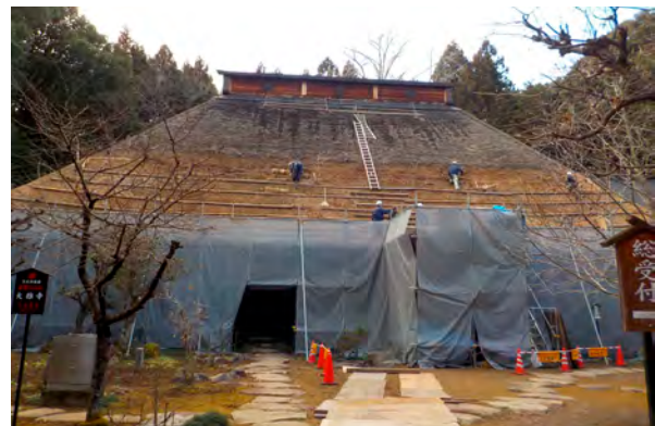
大雄寺本堂屋根差茅修理
