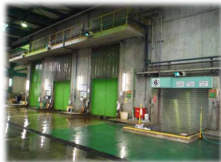
広域クリーンセンター大田原内 もやせるごみ投入口
