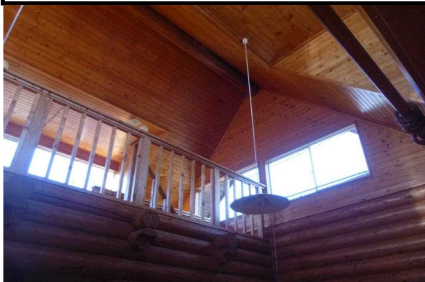
洋室(2階)1階リビングから
