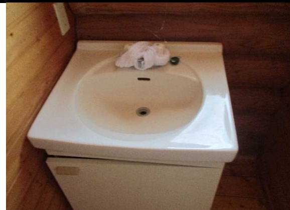
洗面・脱衣所
