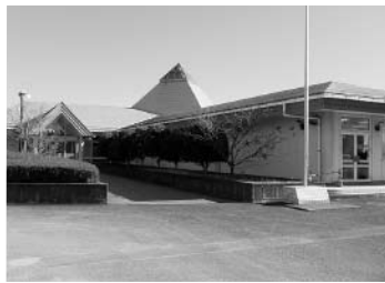
施設(平成4年建築) 多目的ホール、第1・2会議室、和室、調理室、談話コーナー
