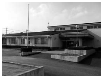
施設：野崎研修センター（昭和63年建築） 第1研修室、第2研修室、第3研修室、和室、調理室
