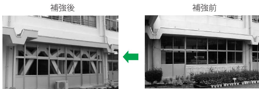
(鉄骨造ブレースの増設)
