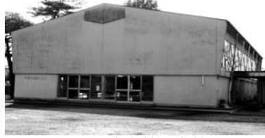
旧川西中学校体育館
